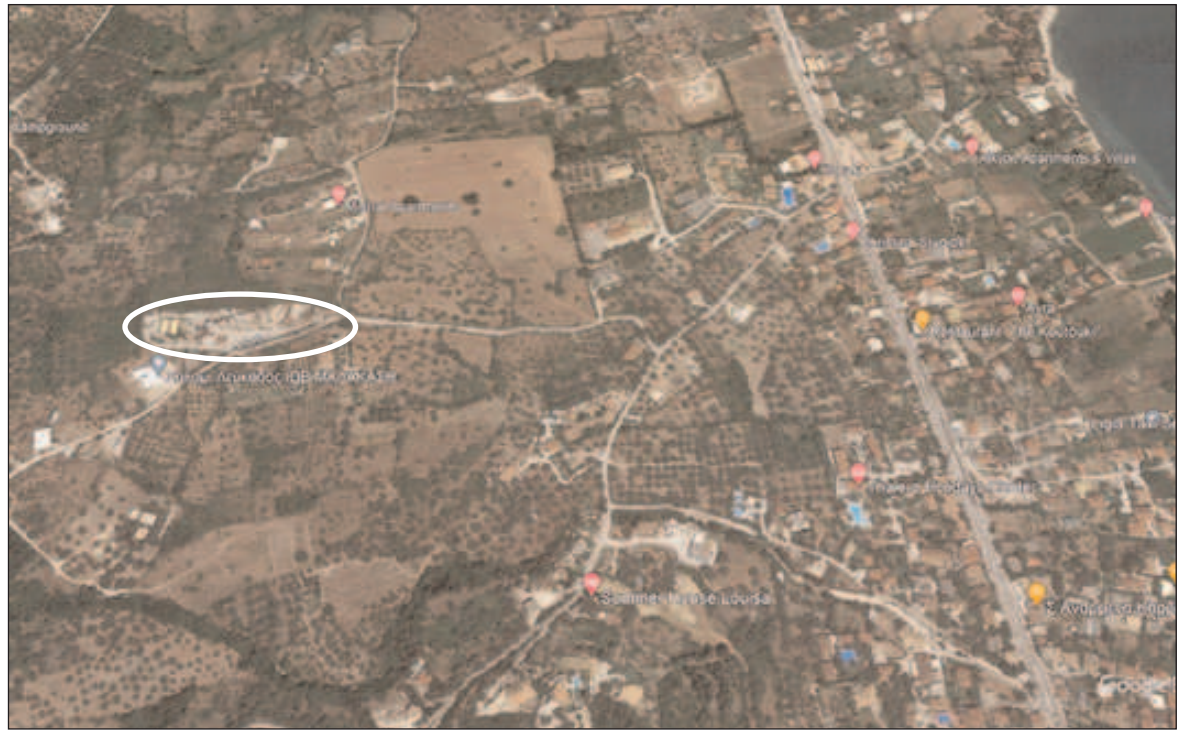
Η θέση στην οποία βρίσκεται η μονάδα παρασκευής ετοίμου σκυροδέματος, που προτίθεται να μπει ξανά σε λειτουργία, σημειώνεται με κύκλο. Δεξιά μας και σε απόσταση 300μ. εκτείνεται ο οικισμός της Λυγιάς.
