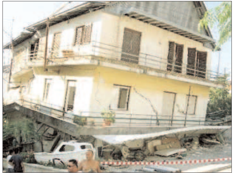
Το τριόροφο κτίριο, που βυθίστηκε χωρίς να καταρεύσει και έγινε εμβληματικό στοιχείο του τότε σεισμού
