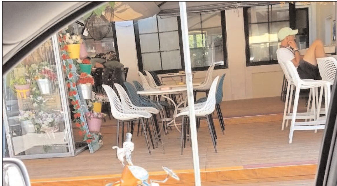
Οι μόνιμες κατασκευές, που έχουν στηθεί εδώ και δύο χρόνια μεταξύ του κτιρίου του ΚΑΠΗ και του δρόμου και “κλείνουν” ολοκληρωτικά το φυσικό φωτισμό και αερισμό του χώρου των ΚΑΠΗ
